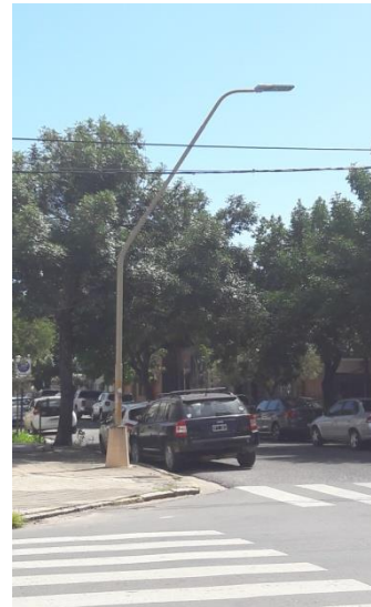
Torres de iluminación
