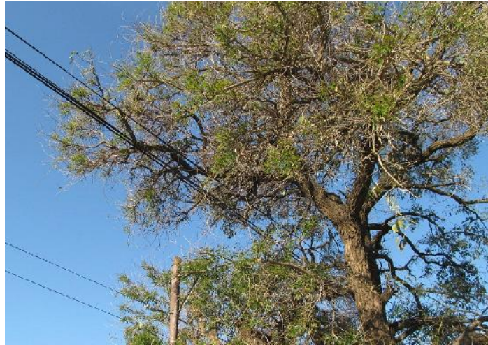
Interferencia con cables de energía eléctrica y telefónica.
